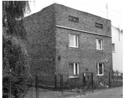
Dom Ksawerego Lemke przy ul. Narutowicza
