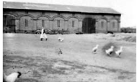
Podwórze folwarku żabikowskiego, z tyłu widoczna murowana stodoła
